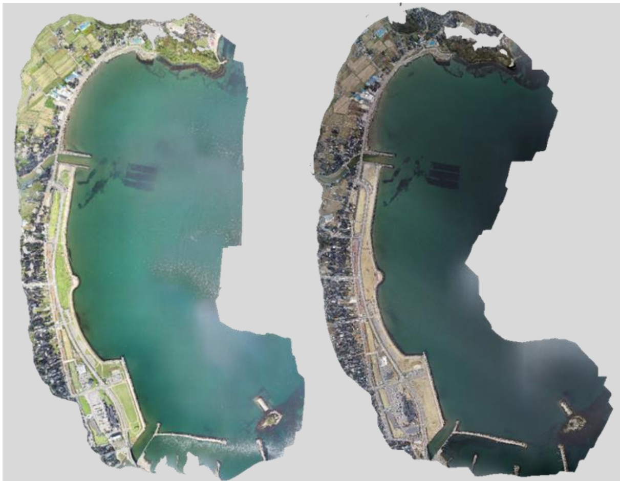
図 2-4 ドローン空撮オルソモザイク画像(左:2018.10.16 撮影 右:2019.02.27 撮影)
