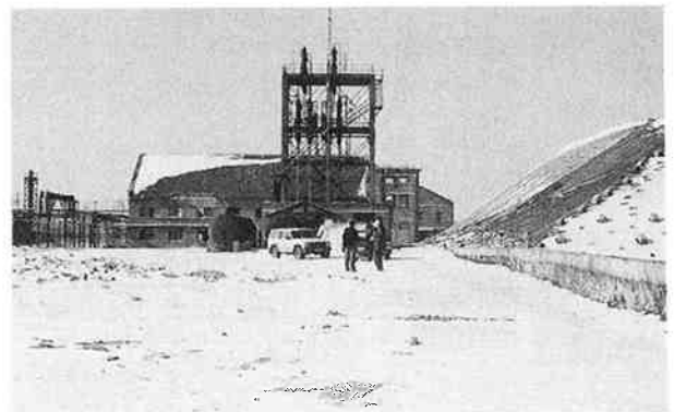
特殊鉄鋼鑄造工場と鉞さいの保管場
